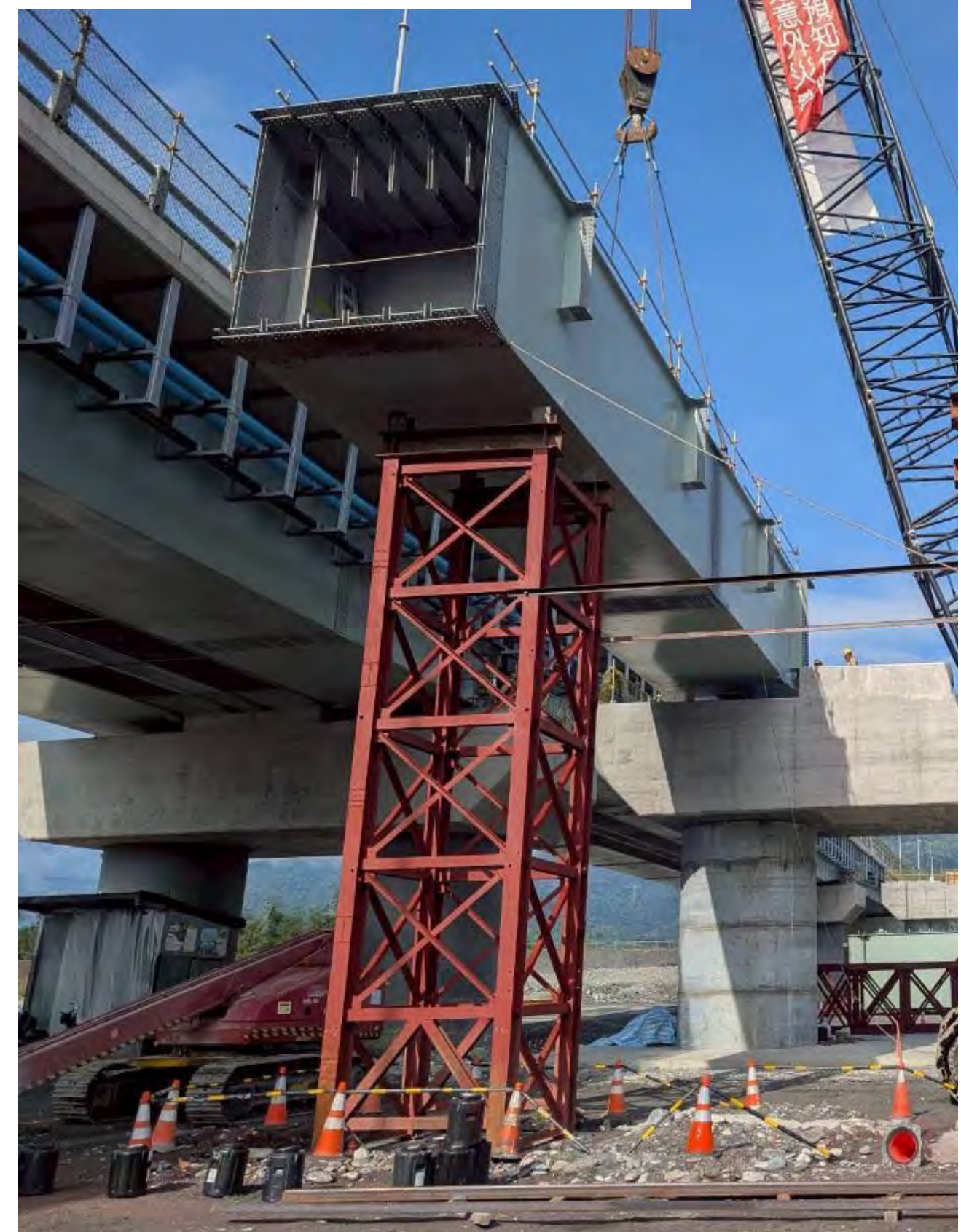
花蓮玉里大橋興建工程
